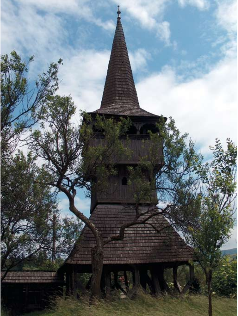
17. kép: A farnasi harangláb. A középkori templom mellett a 18. század elején tölgyfából épült, kőalapzaton álló, szoknyás harangláb jelentős népi építészeti emlék. Harangjai között van egy 1475-ből származó. (Fotó: Fülemile Ágnes, 2005)
