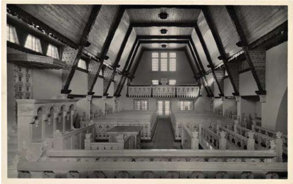
64. kép: A Szeghalmy Bálint műépítész tervezte, 1938-ban átadott miskolci, tetemvári temető református „deszkatemplom” beltere, a Szeghalmy templomtereit jellemző, a nyitott fedélszék érzetét adó, ferde oldalú, gerendavázás „koporsófedéssel” (a Magyar Filmiroda képeslapja, 1940)
