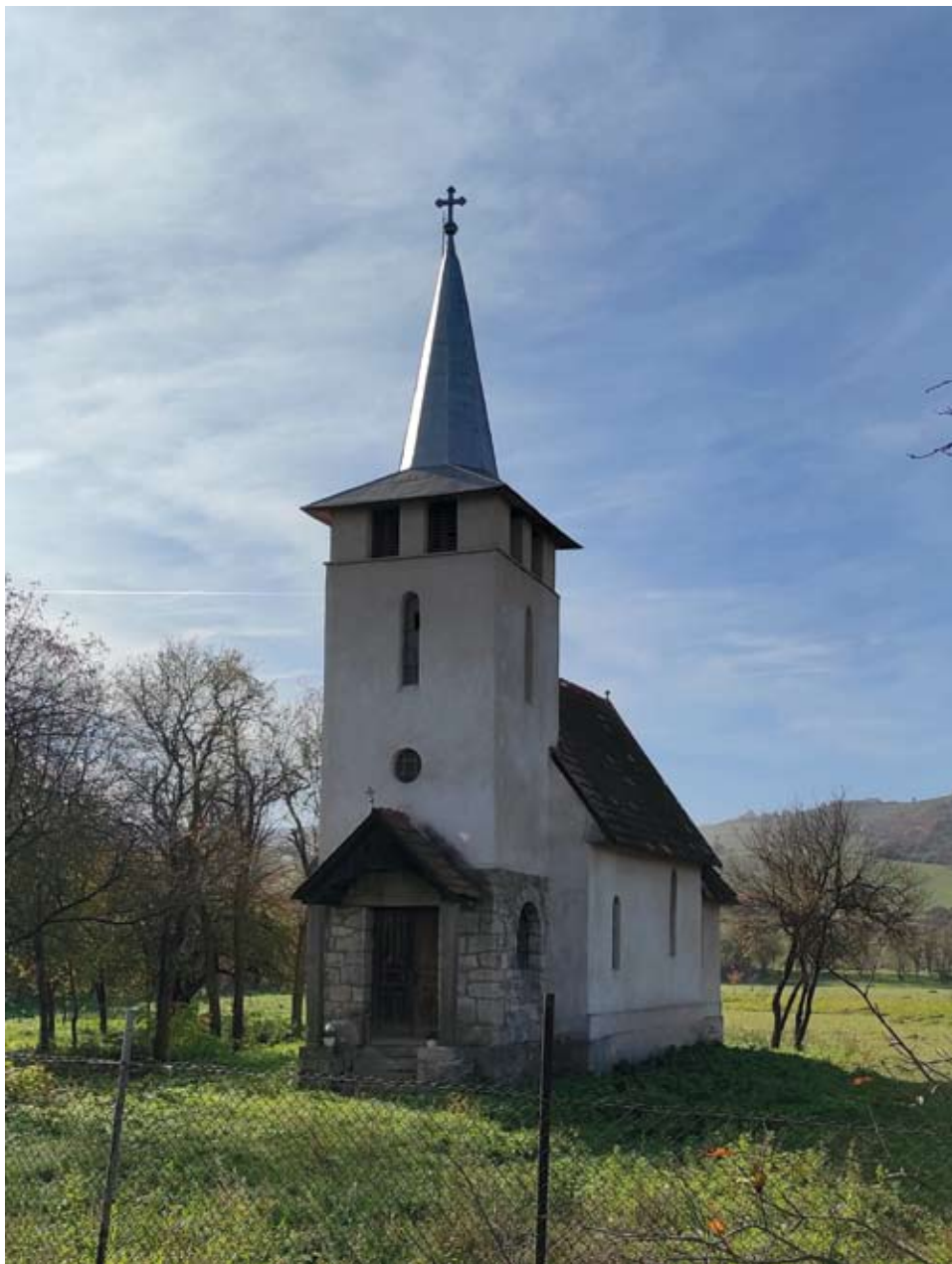
49. kép: Kós Károly 1924-ben készült tervei szerint 1927-ben megépített görögkatolikus (1948 után ortodox) templom Kispetriben. Belső terébe a Sztánán elbontott, onnan megvásárolt, 1795-ben épült román fatemplom részeit telepítették át, amelyhez hozzáépítették a kőtoronyt. (Fotó: Balogh Balázs, 2021)
