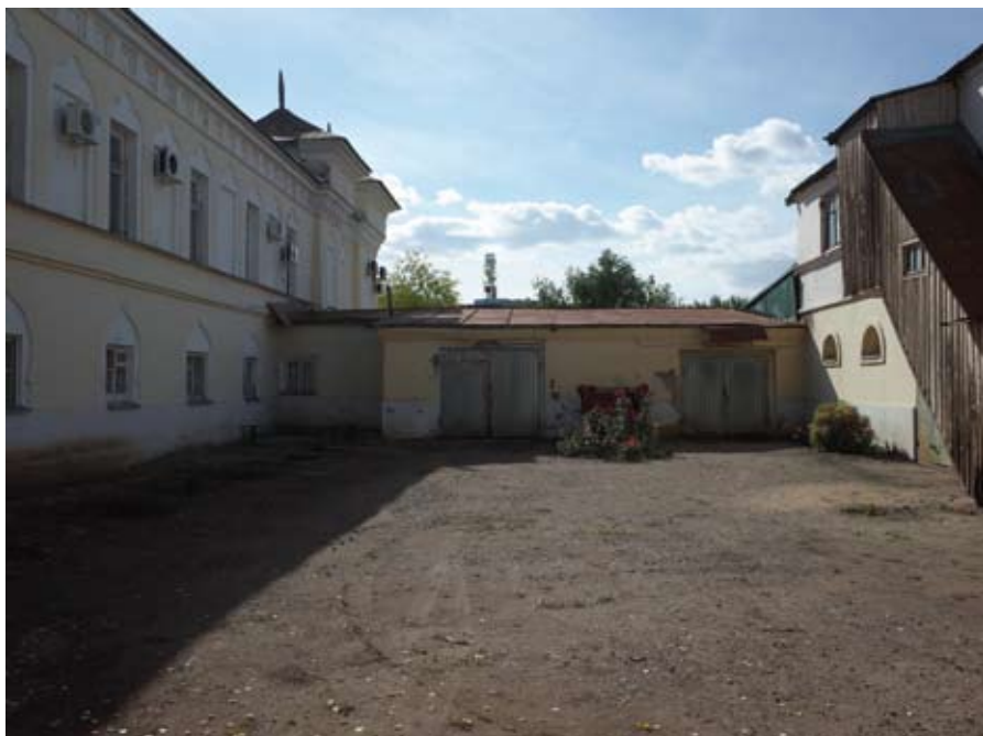
11. kép A Karaván-szeráj épületegyüttes belső udvara, Orenburg. Sántha István, 2021
