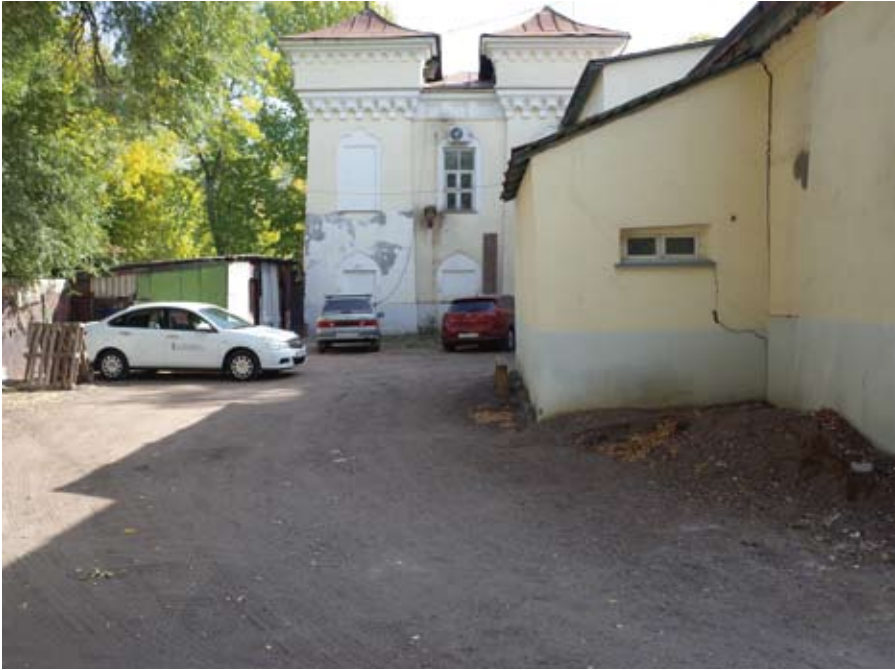
12. kép A Karaván-szeráj épületegyüttes belső udvara, Orenburg. Sántha István, 2021
